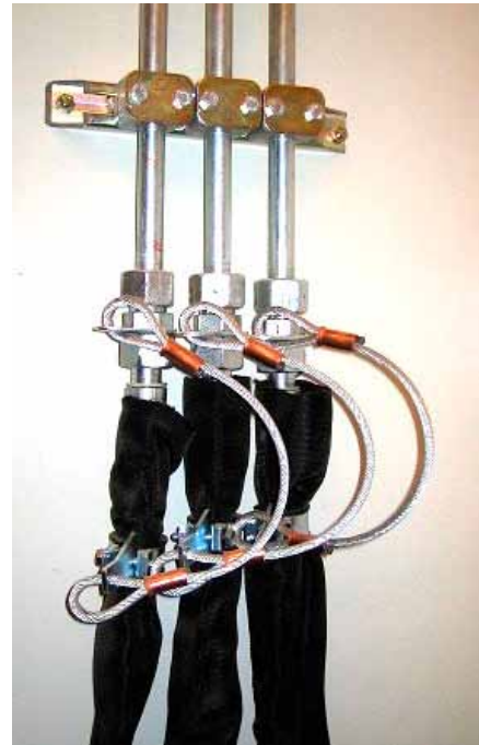
Kuva 7. Letkun päälle vedetty suojauska hajoittaa terävän suihkun vähemmän vaaralliseksi ja varmistusvaijeri estää irtoavan letkun huitaisemisen.
