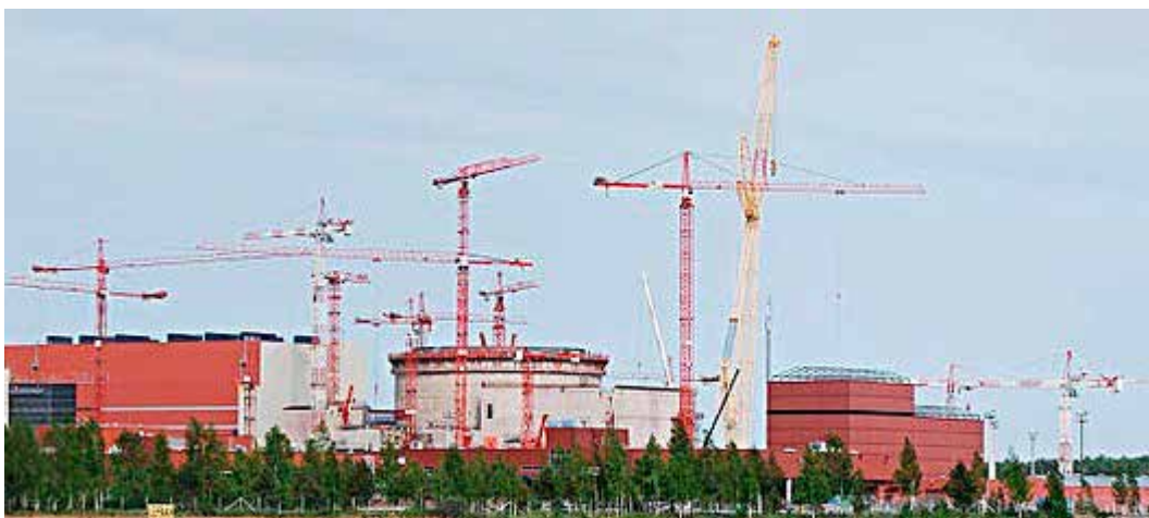
Kuva 41. Suurella työmaalla on useita torninostureita. Nostureiden sijoituksia ja liikealueita suunniteltaessa on otettava huomioon myös se, että nosturit eivät saa törmätä silloinkaan, kun käyttö on lopetettu ja puomi pääsee kääntymään vapaasti tuulen mukana.
