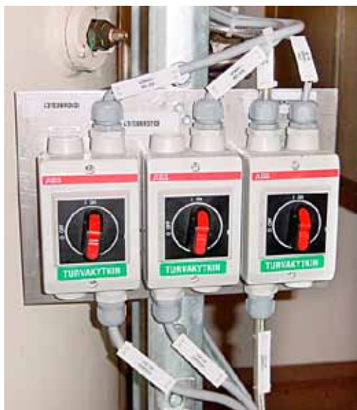
Kuva 30. VÄÄRIN . Yhteen paikkaan ryhmitte- ly johtaa helposti virheisiin etenkin, jos kun- nolliset merkinnät vaikutuksesta puuttuvat.
