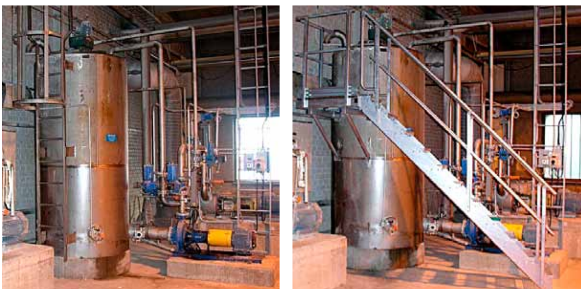
Kuva 9.b Säiliön päälle aikaisemmin meneet tikkaat (vasen kuva) on korvattu portailla (oikea kuva).
